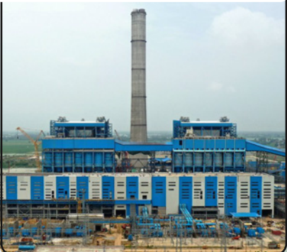
RVNL Power Plant, Buxar
