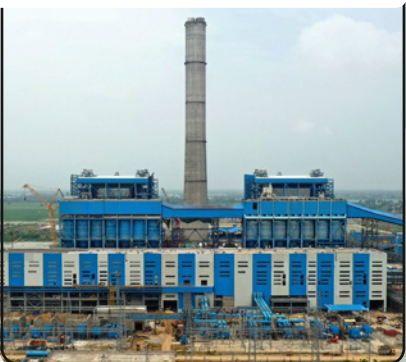
RVNL Power Plant, Buxar
